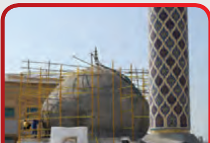
تصاویر آماده سازی گنبد برای کاشی کاری
