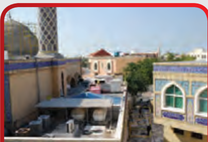
تصاویر آماده سازی گنبد برای کاشی کاری
